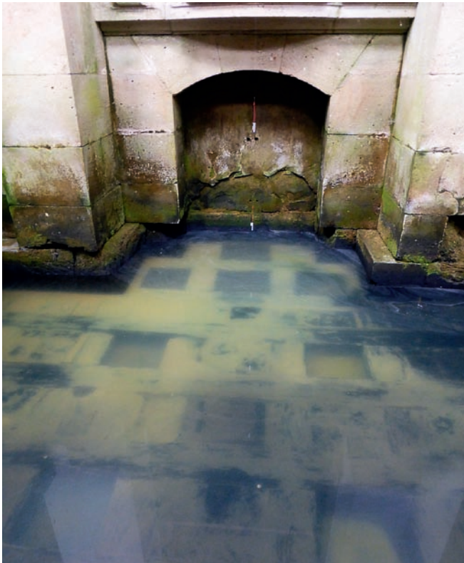
Obr. 125: Dřevěný základový rošt pod hladinou vody kontrolovanou v bazénu schodiště, konvent Plasy.
