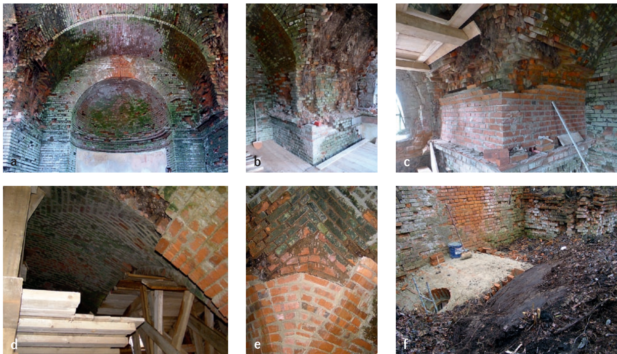
Obr. 104 a–f: Cihelná klenba a zdivo značně narušené povětrností a vegetací – postup opravy, hrobka Krásná Lípa, konec 19. stol.
