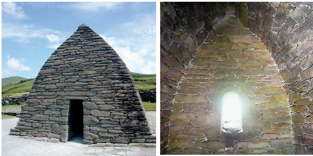
Obr. 65: Parabolická lomená klenba, Gallarus oratory, Irsko, 11.–12. stol.
