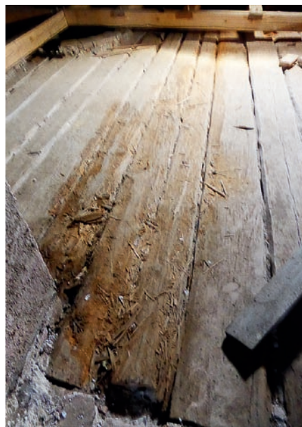
Obr. 154: Malovaný salon pod půdou má povalový strop, který byl v kontaktu s hliněnou mazaninou povrchově napaden hnilobou. Dřevo bylo pečlivě očištěno a opakovaně ošetřeno ochrannými prostředky proti napadení (stav se sleduje), fara, Náměšť n. Oslavou.
