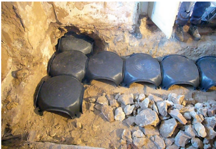
Obr. 33: Větrací kanál pod podlahou z toarovek iglú, Strenice.
