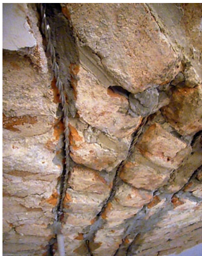
Obr. 100: Zvýšení únosnosti klenby nadezdívkou patek kotvenou šroubovicovou výztuží, Archeologický ústav, Praha.
