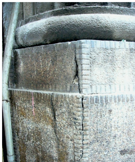
Obr. 17: Stárnutí tzv. ušlechtilých (cementových) omítek; vodojem Poděbrady; palác Lucerna, 20. století.
