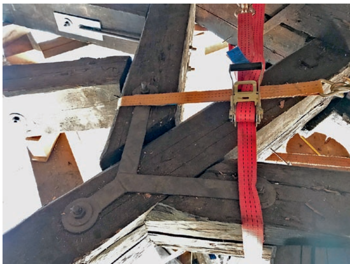
Obr. 139: Ztužení namáhaného spoje ocelovými prvky, Letenský kolotoč, Praha.
