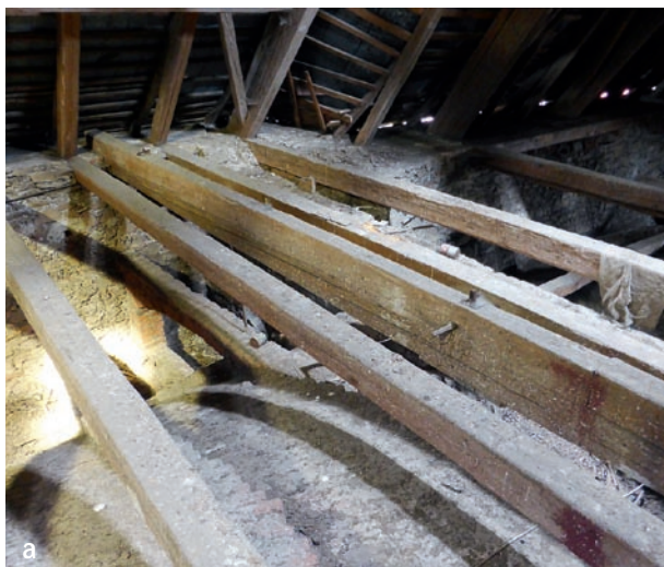
Obr. 97: Kostel sv. Petra a Pavla, Šlapánov, 1733: a – Vysoký nosník mezi vaznými trámy je zazubený trámový rošt, který byl po postavení krovu osazen na pozednici, byly na něj zavěšeny dřevěné ramenáty a osazena šikmá táhla kotvená do patky klenby vyzděné přečnělkově. Vodorovnou reakci klenby při zdění přenášel do obvodové zdi štíhlý segmentový oblouk; b – Klenba presbyteria byla rovněž vyzděna na zavěšené ramenáty. Konstrukce zavěšení byla vzhledem k menším rozpětím podstatně jednodušší, byla ponechána na místě, protože rubové pasy jsou opřené do dřevěných nosníků.
