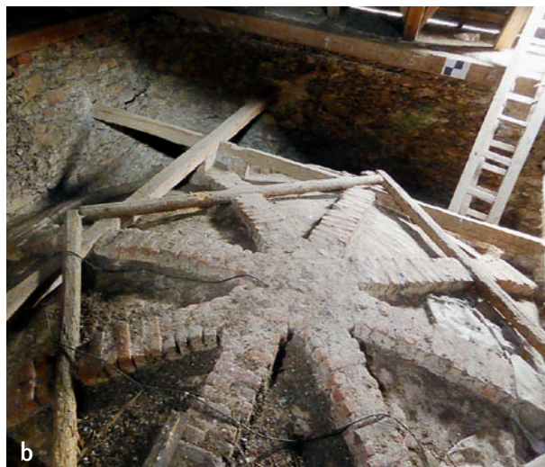
Obr. 97: Kostel sv. Petra a Pavla, Šlapánov, 1733: a – Vysoký nosník mezi vaznými trámy je zazubený trámový rošt, který byl po postavení krovu osazen na pozednici, byly na něj zavěšeny dřevěné ramenáty a osazena šikmá táhla kotvená do patky klenby vyzděné přečnělkově. Vodorovnou reakci klenby při zdění přenášel do obvodové zdi štíhlý segmentový oblouk; b – Klenba presbyteria byla rovněž vyzděna na zavěšené ramenáty. Konstrukce zavěšení byla vzhledem k menším rozpětím podstatně jednodušší, byla ponechána na místě, protože rubové pasy jsou opřené do dřevěných nosníků.
