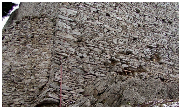
Obr. 130: Založení na nerovném výchozu, hrad Kašperk.
