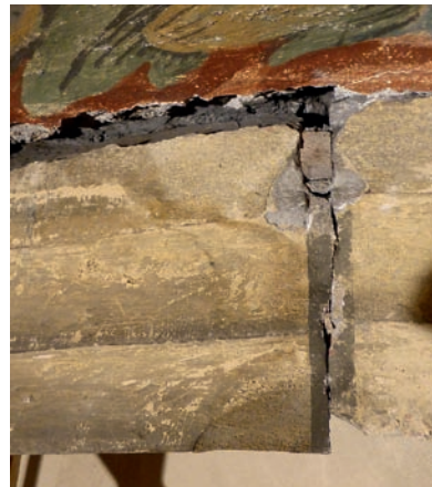
Obr. 87: Klenební žebra odtržená a posunutá po zřícení krovu při požáru; únosnost klenby bez spolupůsobení žebor byla zachována, kostel sv. Petra a Pavla, Mělník, 15. stol.
