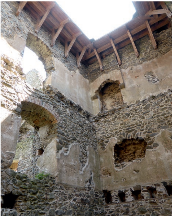
Obr. 46: Možnosti ochrany zachovaných interiérových prvků zříceniny částečným zastřešením, hrad Rokštejn.
