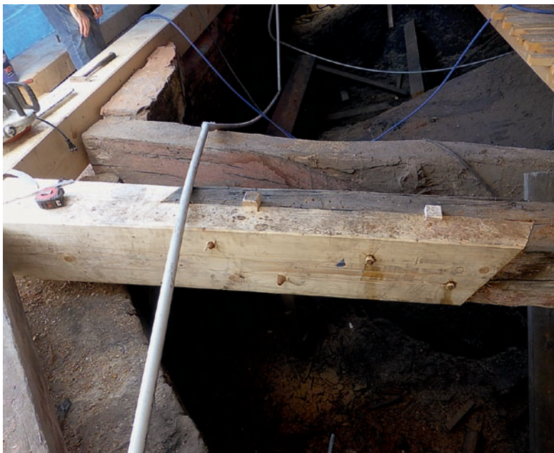
Obr. 140: Celodřevěný spoj, ve kterém spolupůsobí šikmá čela, hmoždíky a dřevěné kolíky, Vlastivědné muzeum, Olomouc.
