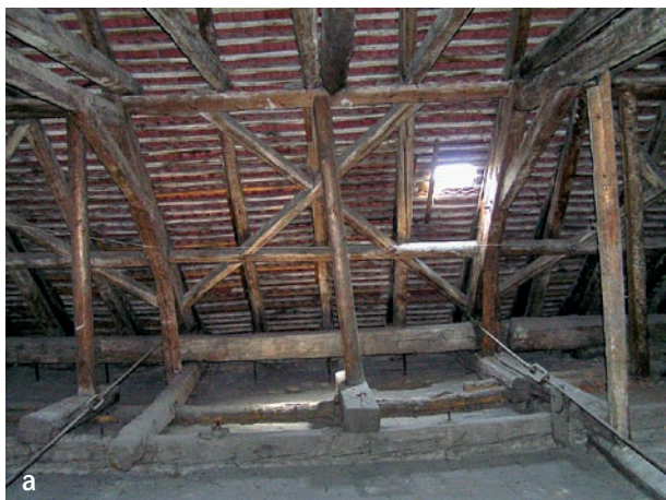
Obr. 144: Dodatečně podepřený krov s ležatou stolicí, zámek Nové Dvory:
