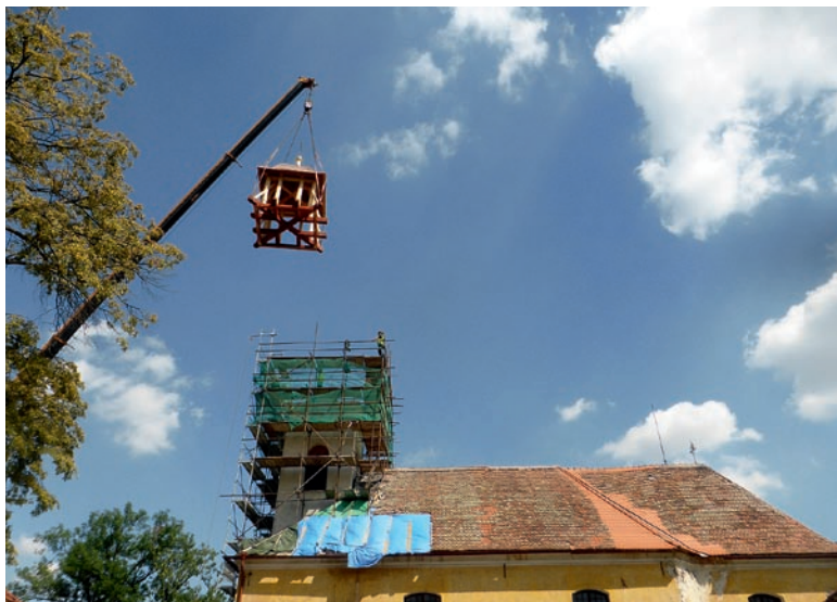
Obr. 148: Přesná kopie silně napadeného krovu věže byla včetně krytiny, kříže a zlacené makovice provedena na zemi a osazena pomocí jeřábu, kostel Nanebevzetí Panny Marie, Kostelní Lhota.
