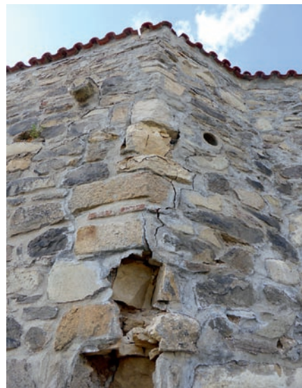
Obr. 16: Nepříznivé působení cementových malt v konstrukcích vystavených povětrnosti, Jihlava, Hněvoín.
