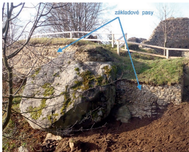
Obr. 121: Základové pasy opřené o skalní výchozy (Orlík u Humpolce).
