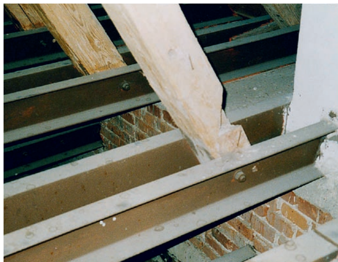
Obr. 141: Nevhodné způsoby nastavení dřevěných proků ocelí; nepřesné vložky a přenos celé reakce jedním svorníkem navíc nevyhovují z hlediska únosnosti, Lemberk.
