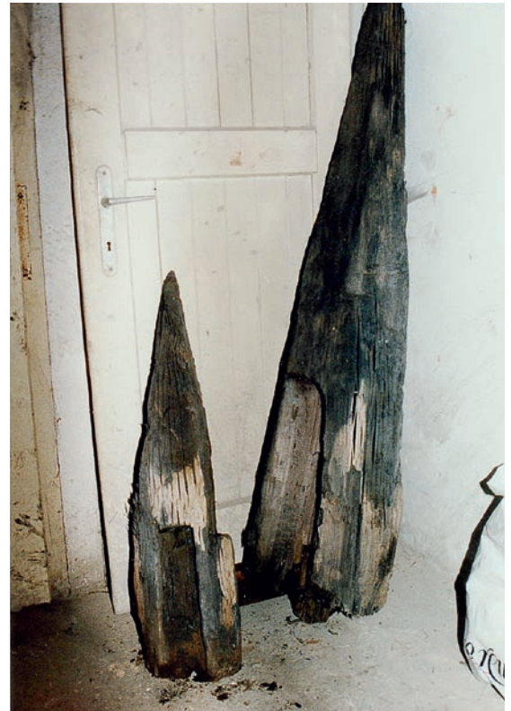
Obr. 126: Opálené dubové piloty základů, konvent Plasy.
