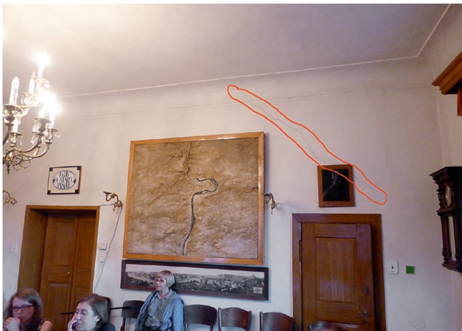
Obr. 170: Šikmou trhlinou se projevuje diagonála v hrázděné příčce, Juditina věž Karlova mostu.
