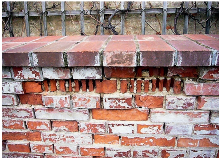
Obr. 36: Nevhodná konstrukce zdi vystavených povětrnosti (slnuté cihly, dutinové cihly, cementová malta), Praha Malá Strana.
