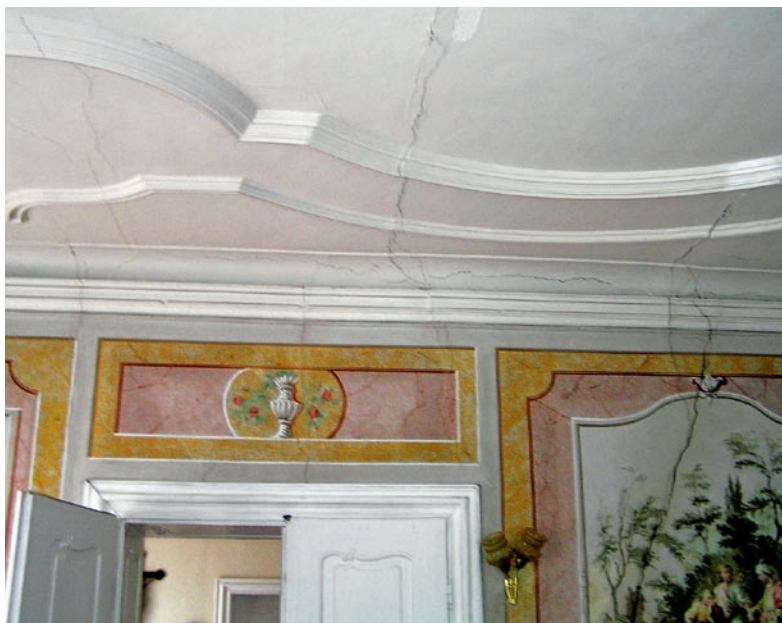
Obr. 154: Malovaný salon pod půdou má povalový strop, který byl v kontaktu s hliněnou mazaninou povrchově napaden hnilobou. Dřevo bylo pečlivě očištěno a opakovaně ošetřeno ochrannými prostředky proti napadení (stav se sleduje), fara, Náměšť n. Oslavou.
