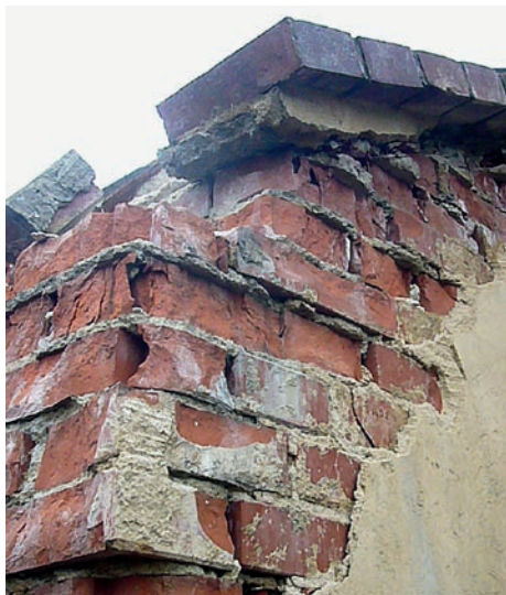
Obr. 36: Nevhodná konstrukce zdi vystavených povětrnosti (slnuté cihly, dutinové cihly, cementová malta), Praha Malá Strana.
