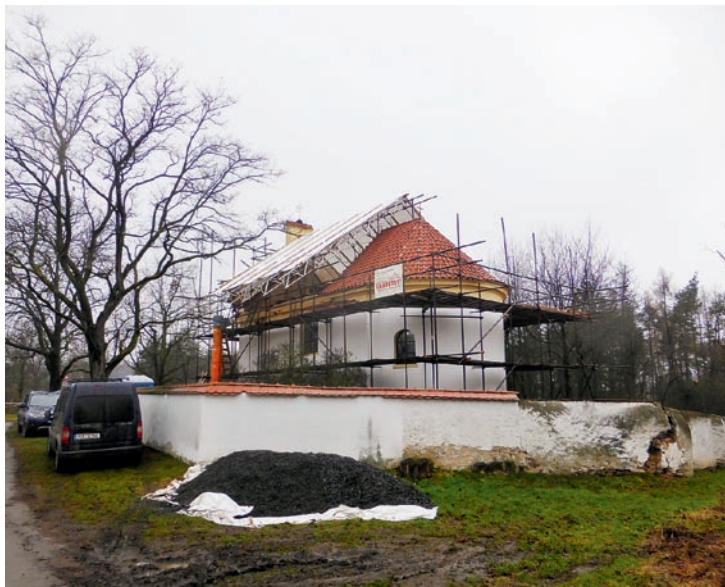
Obr. 143: Provizorní zastřešení celé stauby, kaple sv. Václava, Praha-Suchdol; kostel sv. Michala, Praha-Petřín.
