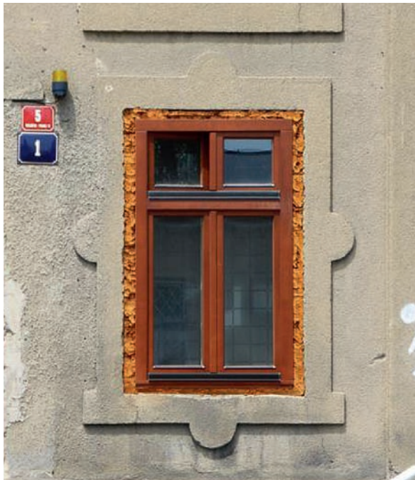
Obr. 20: Zdění nebo osazování stavebních prvků na polyuretanovou pěnu není u chráněných památek přípustné. Důvodem je neprokázaná životnost a použití neautentické technologie. V uvedených příkladech byl změněn detail osazení okna, narušena architektura fasády a zmenšena plocha zasklení, 21. století, Praha Malešice, Lenešice.
