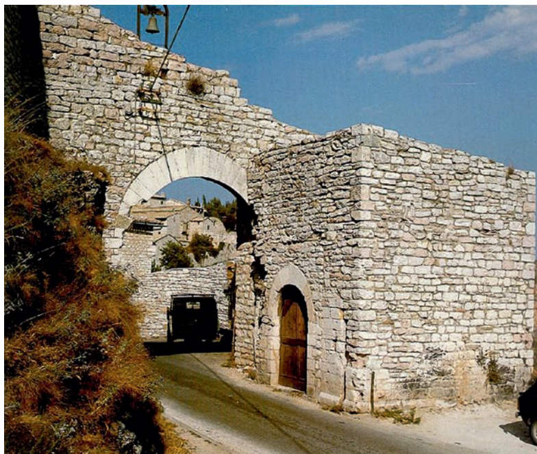
Obr. 74: „Italský“ oblouk – klasický půlkruh zachovává intrados (spodní líc), lomený extrados zvyšuje únosnost, Assisi, 13. stol. (obr. 77).
