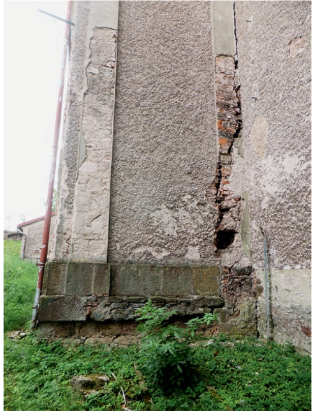
Obr. 177: Trhliny ve zdiu a klenbách jsou evidentně způsobeny poklesy v základech, které zhoršily neuvážené změny a snížení úrovně terénu a zcela nedostatečné odvodnění. Projektant navrhoval sepnutí kostela vodorovnými táhly, které by příčiny poruch neodstranilo a k jejich stabilizaci nepřispělo – při aktivizaci poklesů by v trhlinách působily smykové síly, které v příčném směru měkká táhla nemohou zachytit, kostel sv. Martina, Javorník
