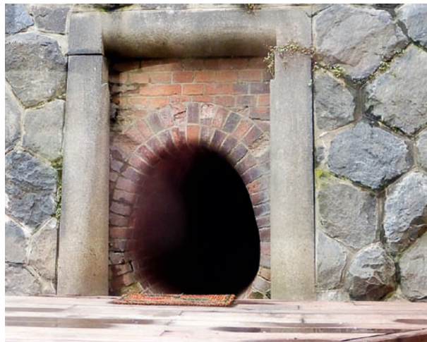
Obr. 59: Vejčitý profil štoly pražské kanalizace, Čertovka.
