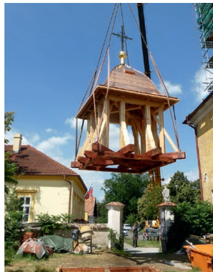
Obr. 148: Přesná kopie silně napadeného krovu věže byla včetně krytiny, kříže a zlacené makovice provedena na zemi a osazena pomocí jeřábu, kostel Nanebevzetí Panny Marie, Kostelní Lhota.
