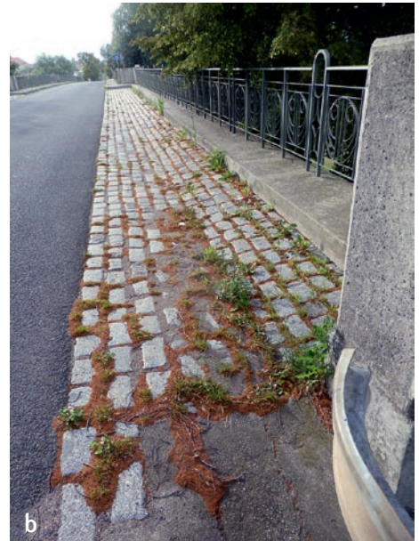
Obr. 114: Kamenný most, Postoloprty: a – nedostatečné odvodnění způsobilo zatékání do zdiva, voda se zadržuje mezi lícem z kvádrů vyspárovaných cementovou maltou a jádrem z lomového zdiva – došlo k odtržení a zřícení líce; b – malý spád, netěsná dlažba, špatné vyústění a zanedbaná údržba odvodňovacího žlábků.
