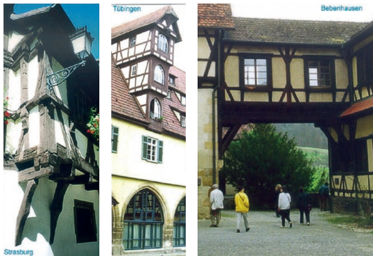
Obr. 160: Hrázděné konstrukce umožňovaly budování lehkých visutých konstrukcí arkýřů, vikýřů a mostů: Strasbourg, Tübingen, Bebenhausen.
