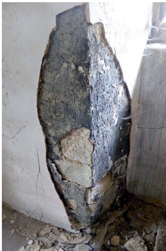
Obr. 29: Opukové zdivo opatřené asfaltovým nátěrem a cementovou omítkou, fara Měrunice.
