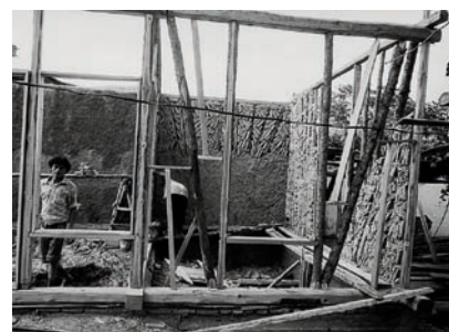
Obr. 165: Hrázděné zdivo z leoného materiálu: a – Damašek, Sýrie; b – Buchara, Uzbekistán, 70. léta 20. století.
