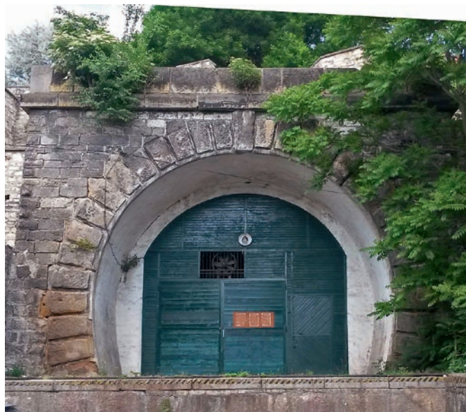
Obr. 76: Podkovovitý oblouk, železniční tunel, Litoměřice, 19. století (obr. 64, 73, 75).
