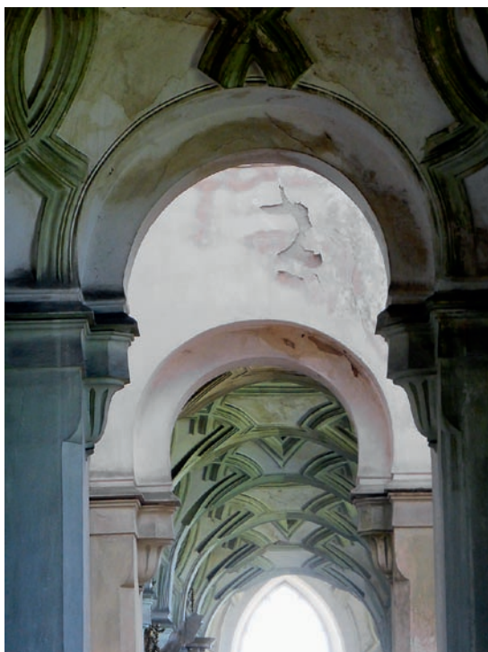
Obr. 75: Nadbýšený oblouk a vysunutí patek zvyšuje únosnost (obr. 64, 73, 76), J. B. Santini: klášterní kostel Nanebevzetí P. Marie v Kladrubech, 1712–1726.
