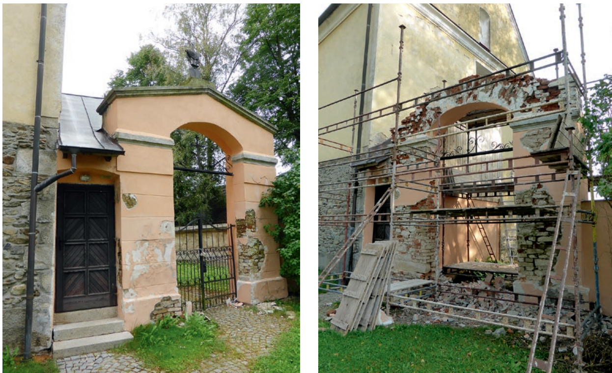
Obr. 39: Zdiwo opatřené několika vrstvami cementových omítek před opravou (vlevo) a po sejmutí cementových omítek (opravo), Horní Bříšťě.
