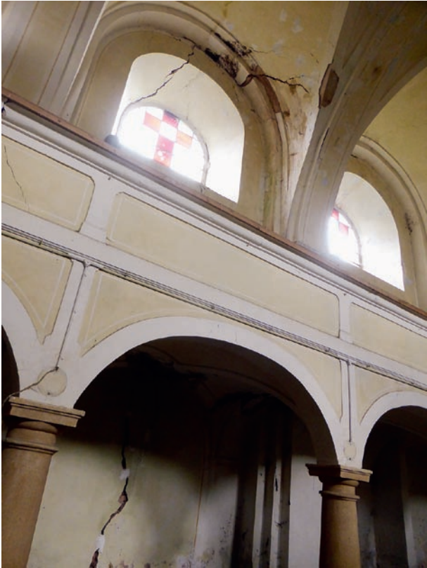
Obr. 177: Trhliny ve zdiu a klenbách jsou evidentně způsobeny poklesy v základech, které zhoršily neuvážené změny a snížení úrovně terénu a zcela nedostatečné odvodnění. Projektant navrhoval sepnutí kostela vodorovnými táhly, které by příčiny poruch neodstranilo a k jejich stabilizaci nepřispělo – při aktivizaci poklesů by v trhlinách působily smykové síly, které v příčném směru měkká táhla nemohou zachytit, kostel sv. Martina, Javorník
