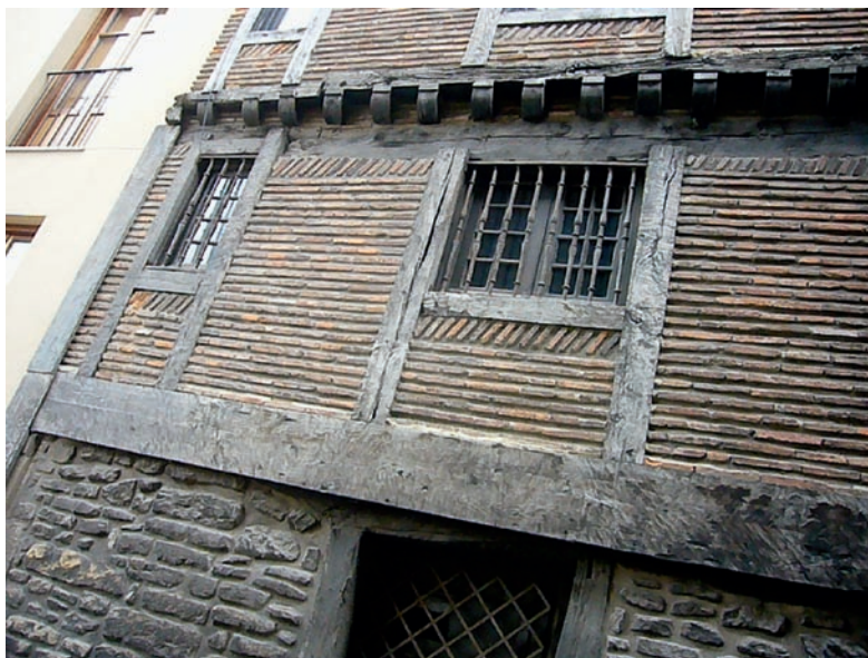
Obr. 161: Dřevěná konstrukce z dubového dřeva nemá diagonály, ale výplně jsou velmi pečlivě vyklínovány proti hornímu dřevu šikmo kladenými cihlami, Vitoria-Gasteiz, Baskicko.
