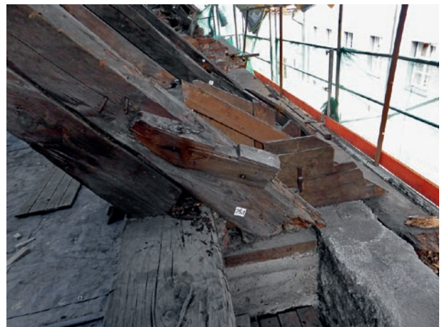
Obr. 147: Všechny krokve a hambalky, pozednice a detaily uložení (včetně pozoruhodných dodatečných proků a některých námětků) vznikly v 15. století. V 19. století byl krov podchycen stojatou stolicí. Díky iniciativnímu přístupu projektanta a staoby mohly být pozednice zachovány na místě – to umožnilo zachovat významnou část historické konstrukce bez rozebírání. Stojatá stolice byla nahrazena novými plnými vazbami a novými vaznicemi, na které byly uloženy krokve starého krovu, které nesou jenom svoji vlastní tíhu. Střešní krytinu včetně izolací nesou nové krokve osazené na nové vaznice. Oprava krovu byla nominována na cenu Patrimonium pro futuro 2021. Český Krumlov.
