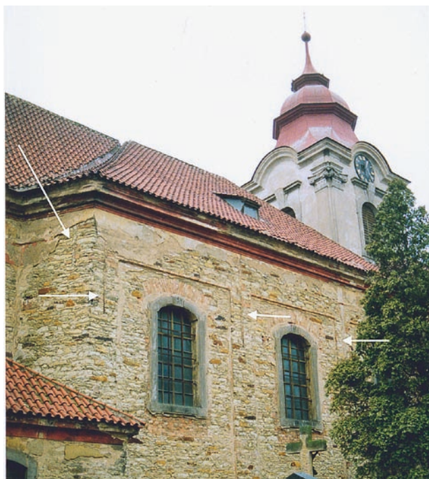
Obr. 84: Závlače táhel pod omítkou fasády, P. P. Columbani: kostel sv. Václava, Ledčice, 1752 (obr. 82, 85, 96).
