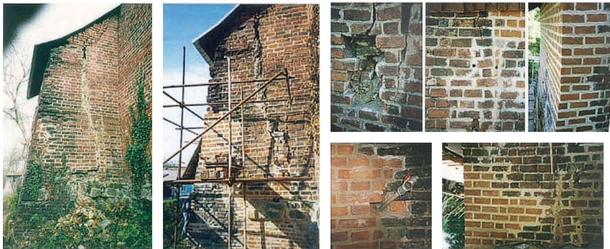
Obr. 31: Oprava hradeb s lícem z režných cihel a jádrem z lomové opuky doplněním vypadlého zdiva, hloubkovým spárováním trhlin a otevřených spar a injektáží, Nymburk.
