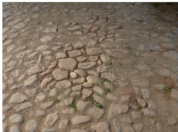
Obr. 110: Doklady zatékání dlažbou mostu: narušené omítky, malta vyplavená ze spar, sintrové krápníky, zelená řasa; vymléte spáry a vegetace v místech, kam dopadá voda protékající klenbou, hrad Bečov.
