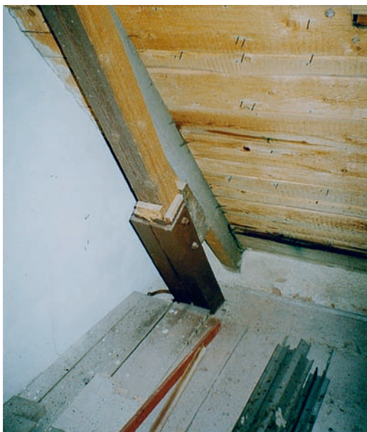
Obr. 141: Nevhodné způsoby nastavení dřevěných proků ocelí; nepřesné vložky a přenos celé reakce jedním svorníkem navíc nevyhovují z hlediska únosnosti, Lemberk.
