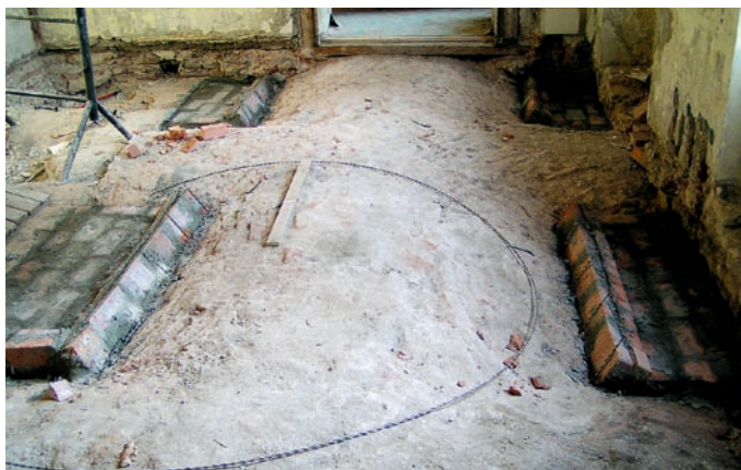
Obr. 100: Zvýšení únosnosti klenby nadezdívkou patek kotvenou šroubovicovou výztuží, Archeologický ústav, Praha.
