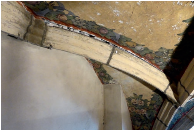
Obr. 87: Klenební žebra odtržená a posunutá po zřícení krovu při požáru; únosnost klenby bez spolupůsobení žebor byla zachována, kostel sv. Petra a Pavla, Mělník, 15. stol.
