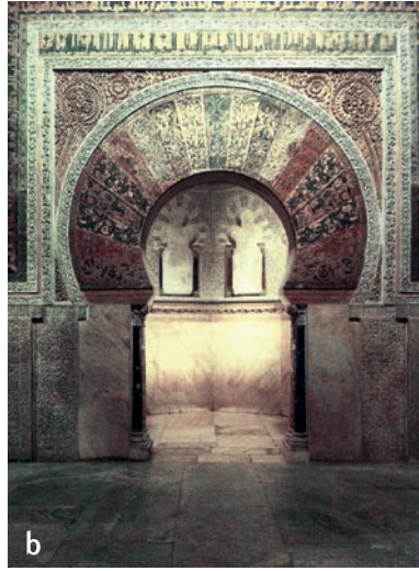
Obr. 73: Islámské oblouky: a, b – podkovovitý oblouk, konstrukce spárořezu; Velká mešita, Cordoba, 10. stol.; c – podkovovitý oblouk, synagoga ben Shoshan, Toledo, 14. stol.;
