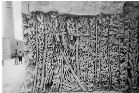
Obr. 163: Hrázdění z tyčoviny, neuspořádaná („entropická“) vazba z nepálených cihel, Chiva, Uzbekistán.
