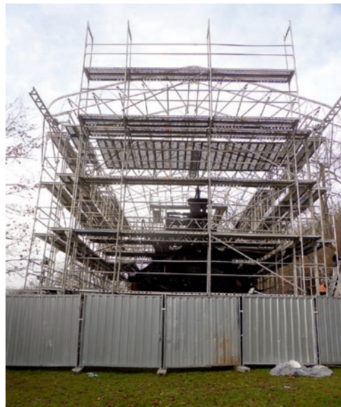
Obr. 143: Provizorní zastřešení celé stauby, kaple sv. Václava, Praha-Suchdol; kostel sv. Michala, Praha-Petřín.
