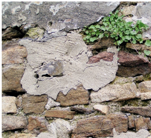
Obr. 30: Lomové zdivo spárované cementovou maltou; městské hradby Jihlava; hrad Orlík.
