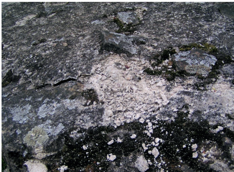
Obr. 16: Nepříznivé působení cementových malt v konstrukcích vystavených povětrnosti, Jihlava, Hněvoín.
