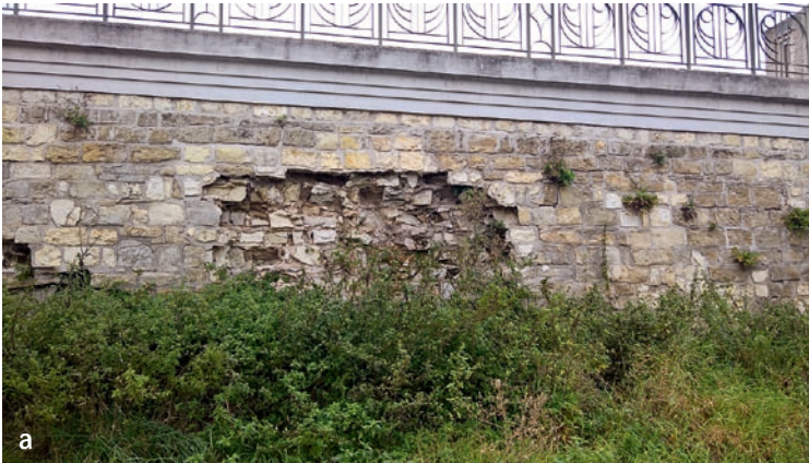
Obr. 114: Kamenný most, Postoloprty: a – nedostatečné odvodnění způsobilo zatékání do zdiva, voda se zadržuje mezi lícem z kvádrů vyspárovaných cementovou maltou a jádrem z lomového zdiva – došlo k odtržení a zřícení líce; b – malý spád, netěsná dlažba, špatné vyústění a zanedbaná údržba odvodňovacího žlábků.
