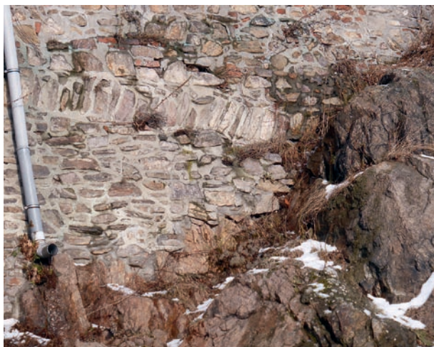
Obr. 122: Dodatečně podezděné základové pasy na neúnosné půdě (Kadaň).
