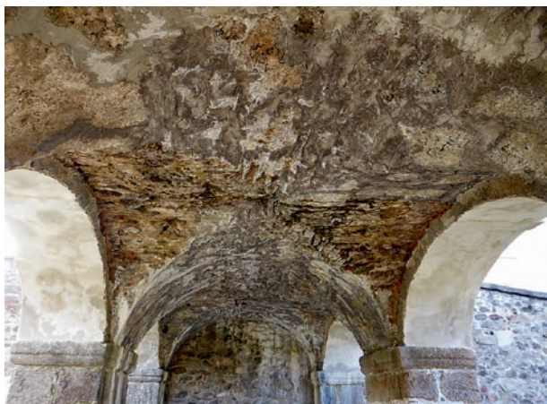
Obr. 110: Doklady zatékání dlažbou mostu: narušené omítky, malta vyplavená ze spar, sintrové krápníky, zelená řasa; vymléte spáry a vegetace v místech, kam dopadá voda protékající klenbou, hrad Bečov.
