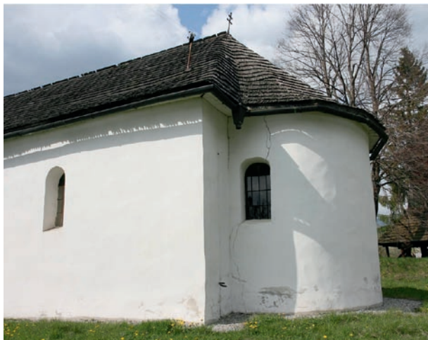
Obr. 4: Trhliny vzniklé v důsledku sedání základů na jílovité půdě po provedení drenáže při patě stauby; Trstené, kostel Všechných svatých [116].
