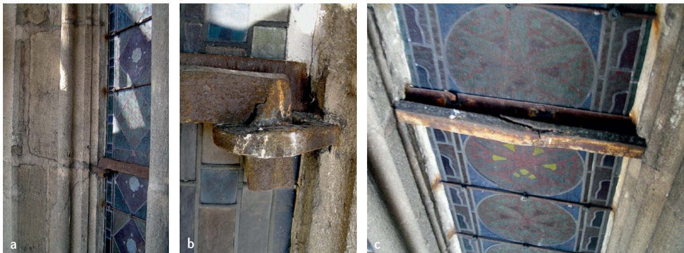
Obr. 93: Táhla obepínají celou staobu – do vodorovných tyčí s oky zazděných v meziokenních pilířích, jsou v oknech osazeny tyče s háky. A – před osazením byly háky ohřáty ve výhni, po vychladnutí se táhla vypnula. B – trhlina v háku vznikla při násilném zatlučení oka. C – koroze v místě svaru. Chrám sv. Barbory, Kutná Hora, 15. stol.
