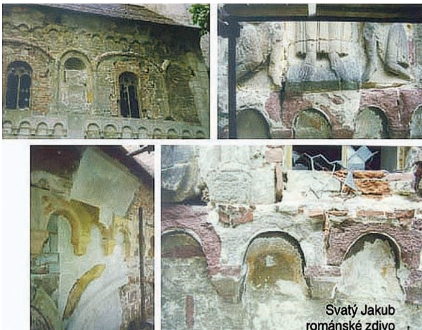
Obr. 32: Restaurování a injektáž narušeného románského zdiva, Sv. Jakub.
