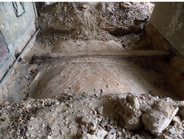
Obr. 95: Dřevěná táhla nad klenbami (obr. 82), zámek v Zákupech, 18. stol.
