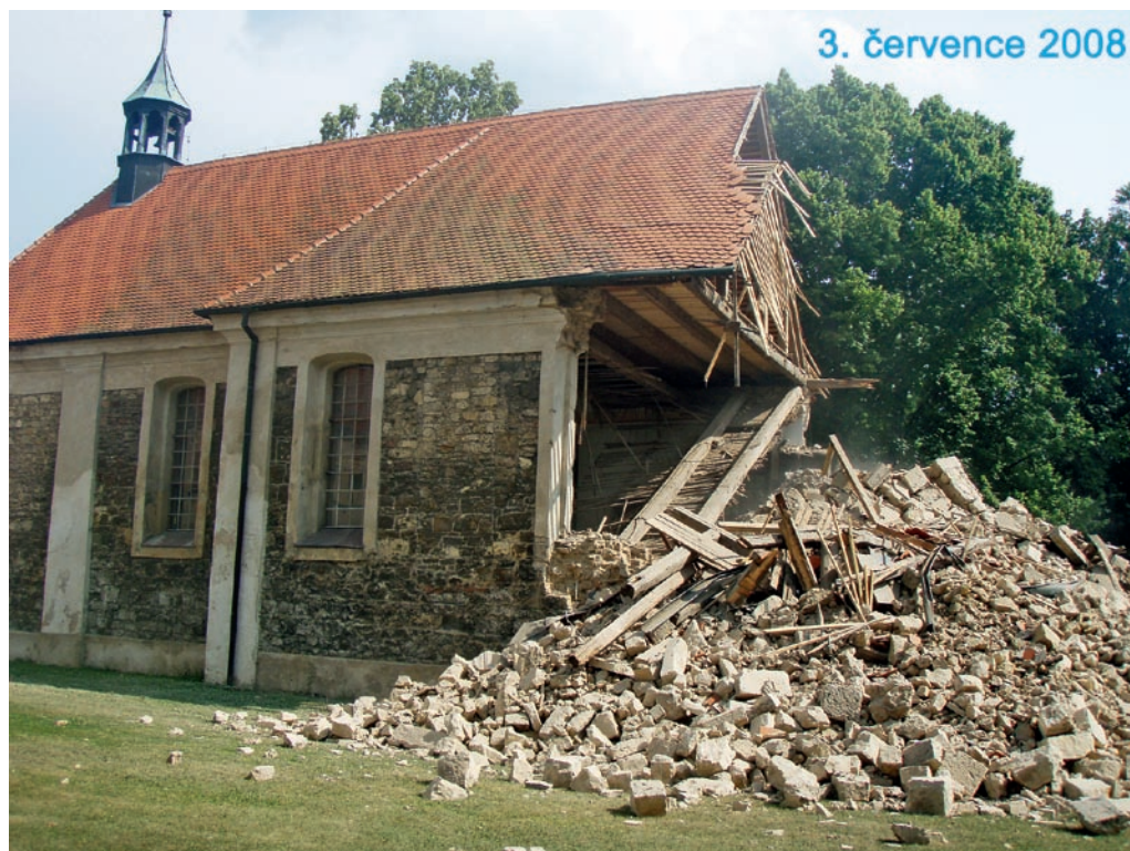
Obr. 173: Využití matematického modelování při analýze příčin havárie věže, kostel sv. Šimona a Judy, Lenešice: a – zřícení věže;
