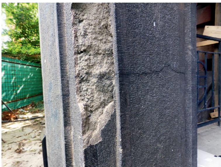
Obr. 17: Stárnutí tzv. ušlechtilých (cementových) omítek; vodojem Poděbrady; palác Lucerna, 20. století.
