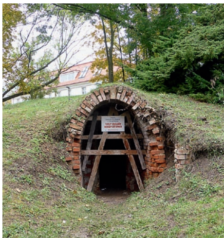
Obr. 60: Parabolická klenba protiletického krytu, kampus University J. E. Purkyně, Ústí n. L., 40. léta 20. století.
