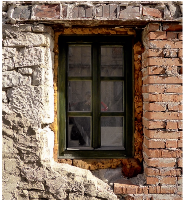
Obr. 20: Zdění nebo osazování stavebních prvků na polyuretanovou pěnu není u chráněných památek přípustné. Důvodem je neprokázaná životnost a použití neautentické technologie. V uvedených příkladech byl změněn detail osazení okna, narušena architektura fasády a zmenšena plocha zasklení, 21. století, Praha Malešice, Lenešice.
