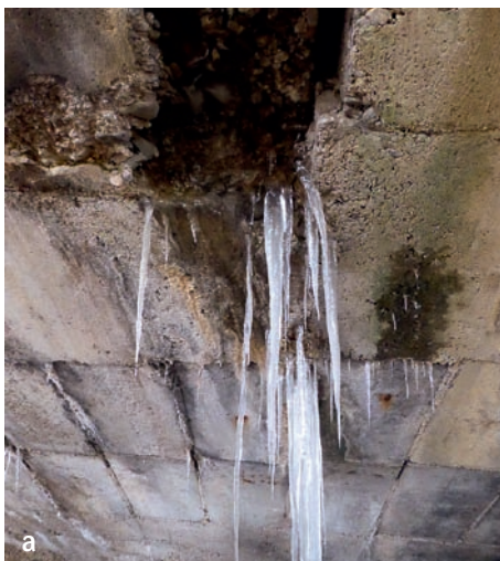
Obr. 112: Betonový most, Praha-Libeň: a – Zatékání pracovními a dilatačními sparami – ledové ram-pouchy; b – Stav „dila-tační“ spáry mostu.
