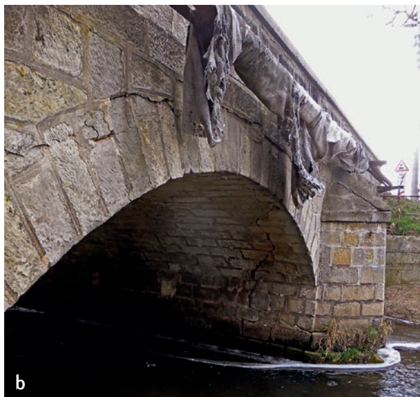
Obr. 111: Kamenný most, Zákupy: a – Havarijní stav odvodnění mostu: trhliny, nedostatečný spád a vyústění odvodňovacího žlábků, otevřené spáry koruny parapetu, zanedbaná údržba; b – důsledkem zatékání „odvodňovacím“ žlábkem je odtržení zdiva parapetu od klenby mostu a trhliny v klenbě a pilíři pod místy, kudy zatéká.
