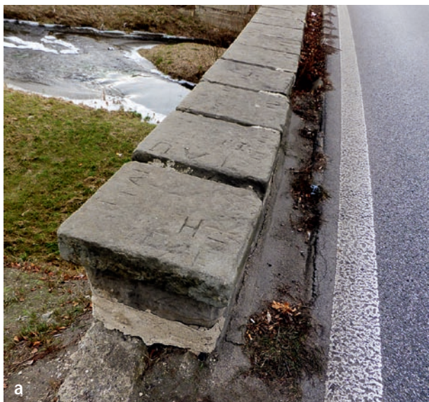
Obr. 111: Kamenný most, Zákupy: a – Havarijní stav odvodnění mostu: trhliny, nedostatečný spád a vyústění odvodňovacího žlábků, otevřené spáry koruny parapetu, zanedbaná údržba; b – důsledkem zatékání „odvodňovacím“ žlábkem je odtržení zdiva parapetu od klenby mostu a trhliny v klenbě a pilíři pod místy, kudy zatéká.
