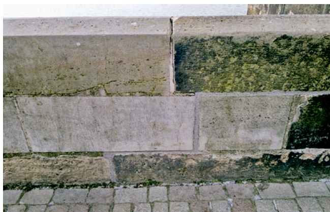
Obr. 112: Betonový most, Praha-Libeň: a – Zatékání pracovními a dilatačními sparami – ledové ram-pouchy; b – Stav „dila-tační“ spáry mostu.
