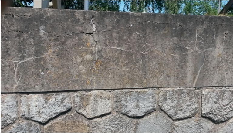
Obr. 45: Porovnání životnosti kamenného kyklopského zdiva a železobetonové koruny, Batův kanál, 30. léta 20. století.
