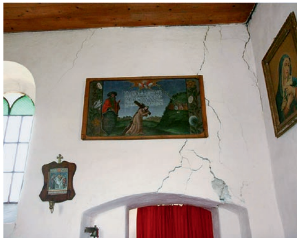
Obr. 4: Trhliny vzniklé v důsledku sedání základů na jílovité půdě po provedení drenáže při patě stauby; Trstené, kostel Všechných svatých [116].
