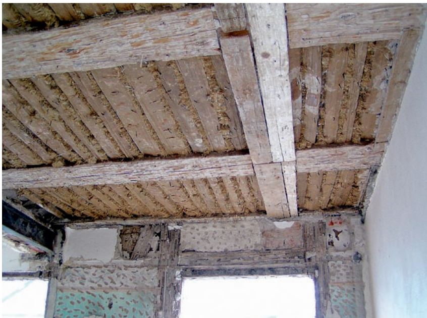
Obr. 150: Strop z částečně hraněné kulatiny osazené do drážky ve stropních trámech, na kulatině je hliněná mazanina.
