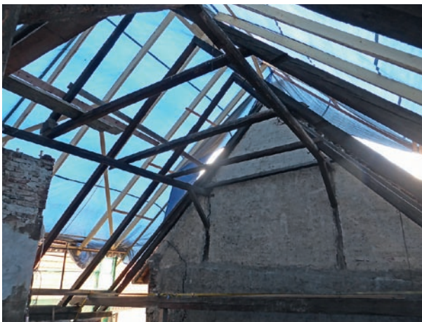
Obr. 147: Všechny krokve a hambalky, pozednice a detaily uložení (včetně pozoruhodných dodatečných proků a některých námětků) vznikly v 15. století. V 19. století byl krov podchycen stojatou stolicí. Díky iniciativnímu přístupu projektanta a staoby mohly být pozednice zachovány na místě – to umožnilo zachovat významnou část historické konstrukce bez rozebírání. Stojatá stolice byla nahrazena novými plnými vazbami a novými vaznicemi, na které byly uloženy krokve starého krovu, které nesou jenom svoji vlastní tíhu. Střešní krytinu včetně izolací nesou nové krokve osazené na nové vaznice. Oprava krovu byla nominována na cenu Patrimonium pro futuro 2021. Český Krumlov.
