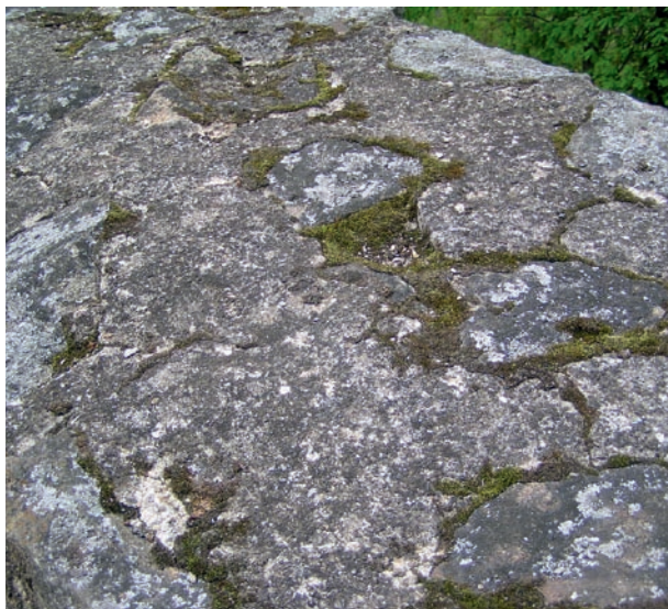
Obr. 30: Lomové zdivo spárované cementovou maltou; městské hradby Jihlava; hrad Orlík.
