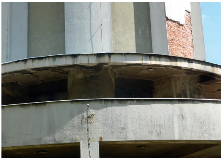
Obr. 17: Stárnutí tzv. ušlechtilých (cementových) omítek; vodojem Poděbrady; palác Lucerna, 20. století.
