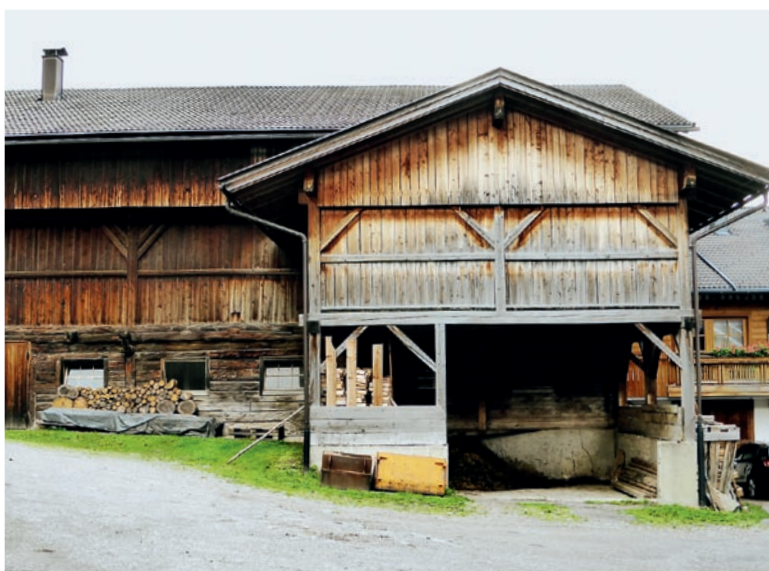
Obr. 135: Poorchová úprava dřeva: a, b – původní hnědá patina překrytá dehtovými nátěry, které jsou místy již vymyté na holé dřevo, Sobotka; c – nově opravené roubení, natřené vápnem, Sobotka; d – postupná tvorba přirozené patiny na dřevě: světle hnědá barva v chráněných místech tmavne; dřevo, na které prší, šedne; Obertilliach, Tyrolsko.
