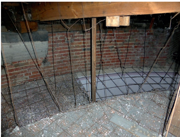
Obr. 168: Podhled ve tvaru klenby ze Staussova pletiva nese mřížovina z ocelových drátů kotvená do stěn, zavěšená a vzepřená na dřevěnou konstrukci pod krovem. Mřížovina a pletivo jsou spojovány vázacím drátem, závěsy jsou vypnuty rádlouáním. Unikátně zachovanou konstrukci, která byla částečně narušena zatékáním, se podařilo zachovat, kostel M. Jana Husa z 30. let 20. století, Česká Lípa.
