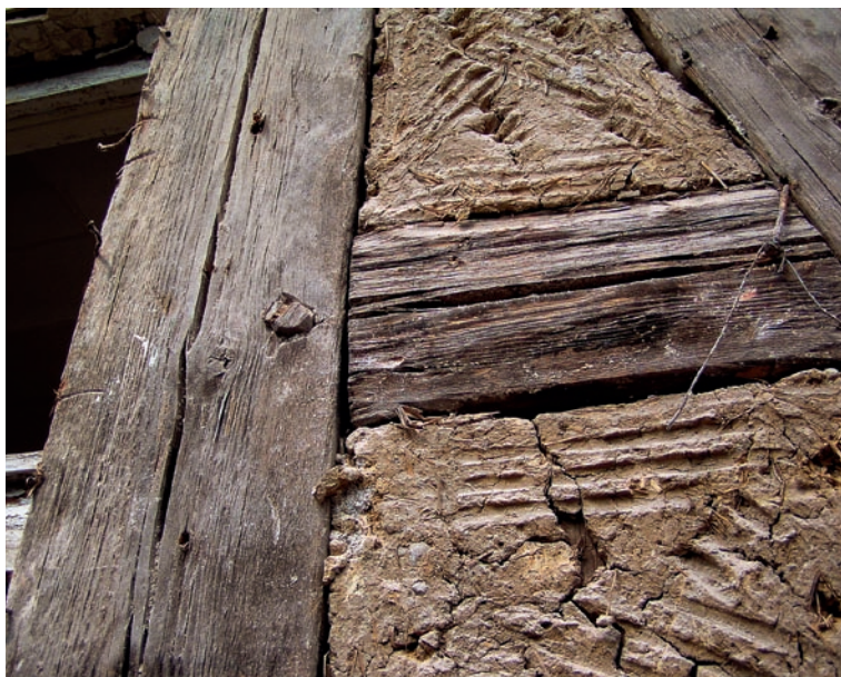
Obr. 167: Hrázděná stěna měla vápennou omítku, po jejím odstranění se objevila hlíněná mazanina se slámou na výplni z dřevěné tyčoviny. Stopy prstů mají význam pro spojení mazaniny s omítkou, K. Vary, 18. století (?)
