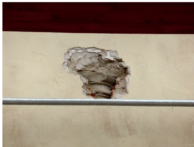
Obr. 108: Projektant považoval trhliny ve sparách zazděných arkád renesančního zámku za statickou poruchu, navrhl ocelovou konstrukci, na kterou pomocí vlepených táhel ovyvěsil klenby; nebyl proveden stavebně historický průzkum – kamenné sloupky arkád a patky kleneb jsou v plném rozsahu zachovány; Nové Syrovice.
