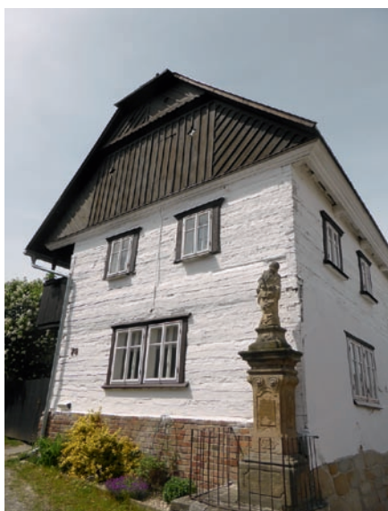
Obr. 135: Poorchová úprava dřeva: a, b – původní hnědá patina překrytá dehtovými nátěry, které jsou místy již vymyté na holé dřevo, Sobotka; c – nově opravené roubení, natřené vápnem, Sobotka; d – postupná tvorba přirozené patiny na dřevě: světle hnědá barva v chráněných místech tmavne; dřevo, na které prší, šedne; Obertilliach, Tyrolsko.
