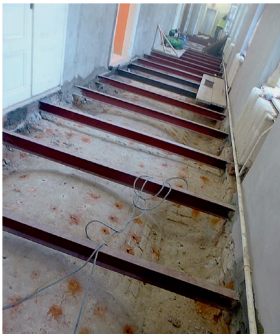
Obr. 108: Projektant považoval trhliny ve sparách zazděných arkád renesančního zámku za statickou poruchu, navrhl ocelovou konstrukci, na kterou pomocí vlepených táhel ovyvěsil klenby; nebyl proveden stavebně historický průzkum – kamenné sloupky arkád a patky kleneb jsou v plném rozsahu zachovány; Nové Syrovice.
