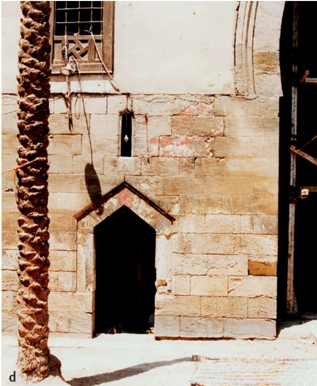
d – přímá klenba – vyznačený spárořez; Káhira, 14. stol.; e – románský ústupkový portál – lomený extrados, půlkruhový intrados, všechny oblouky mají společné spáry (nejsou převázány), které směřují do středu. Spodní část portálu byla zděna bez podpory. Možný islámský vliv. („Byzantská“ brána kostela sv. Medarda), Thouars, Francie, 12. stol.
