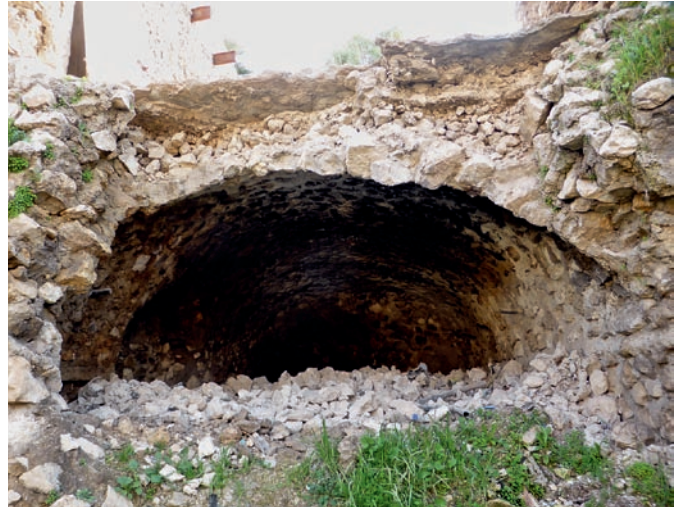
Obr. 19: Klenba z lomového kamene zděná bez podpory na sádrovou maltu, Alqosh, Irák.
