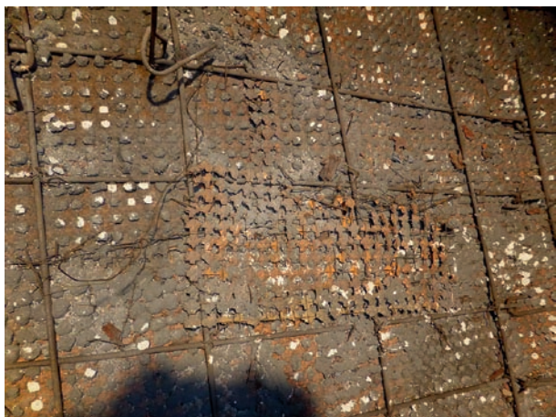
Obr. 168: Podhled ve tvaru klenby ze Staussova pletiva nese mřížovina z ocelových drátů kotvená do stěn, zavěšená a vzepřená na dřevěnou konstrukci pod krovem. Mřížovina a pletivo jsou spojovány vázacím drátem, závěsy jsou vypnuty rádlouáním. Unikátně zachovanou konstrukci, která byla částečně narušena zatékáním, se podařilo zachovat, kostel M. Jana Husa z 30. let 20. století, Česká Lípa.
