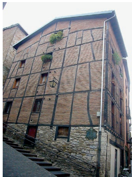
Obr. 161: Dřevěná konstrukce z dubového dřeva nemá diagonály, ale výplně jsou velmi pečlivě vyklínovány proti hornímu dřevu šikmo kladenými cihlami, Vitoria-Gasteiz, Baskicko.
