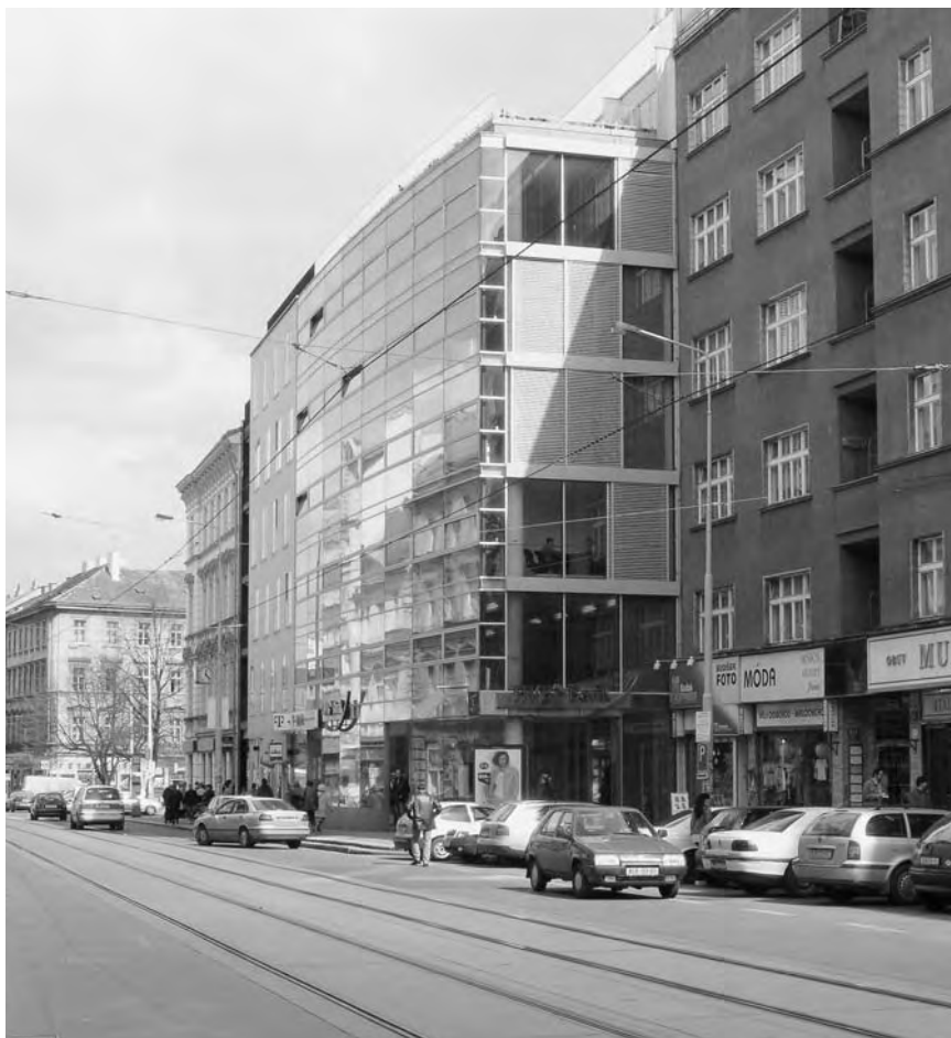
MPZ Smíchov (Praha), Štefánikova ulice. Výrazně kontrastní novostavba vytvořila hmotovým řešením i architektonickým pojetím přijatelný přechod mezi hmotově i slohově značně odlišnými objekty domovního bloku. Foto 2004.
