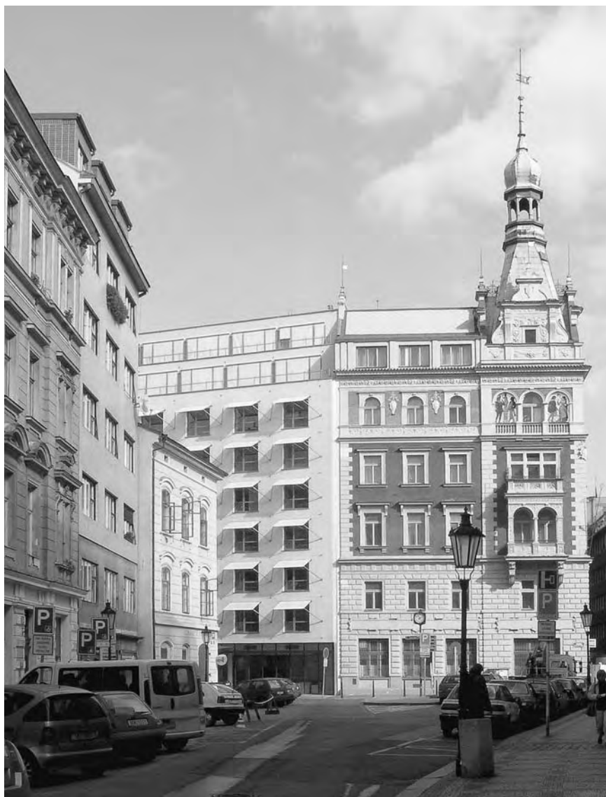
Pražská památková rezervace, Staré Město, novostavba hotelu Josef čp. 693/I v Rybné ulici při pohledu z Masné ulice. Moderní kontextuální stavba dodržuje výškovou hladinu, úspěšně aplikuje princip ustupujících horních pater a střídavým rastroem průčelí se vhodně začleňuje do okolního prostředí. Foto 2004.
