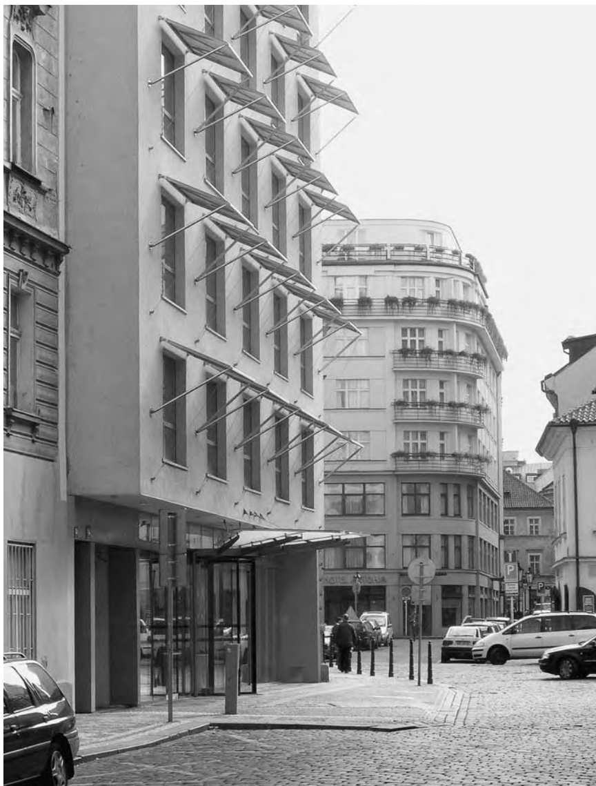
Pražská památková rezervace, Staré Město, novostavba čp. 693/I v Rybné ulici. Významnou roli v příznivém začlenění novostavby se zcela lapidární fasádou mají překvapivě slunolamy nad okny, dodávající průčelí plasticitu, charakteristickou pro většinu okolní zástavby, pro niž je typická štuková výzdoba. Foto 2004.
